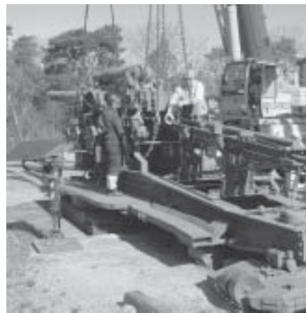
Koppling inför lyftet
